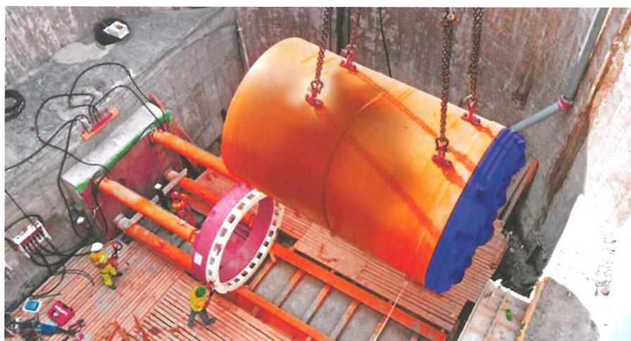
Trình tự lắp đặt thiết bị khoan - kích.
